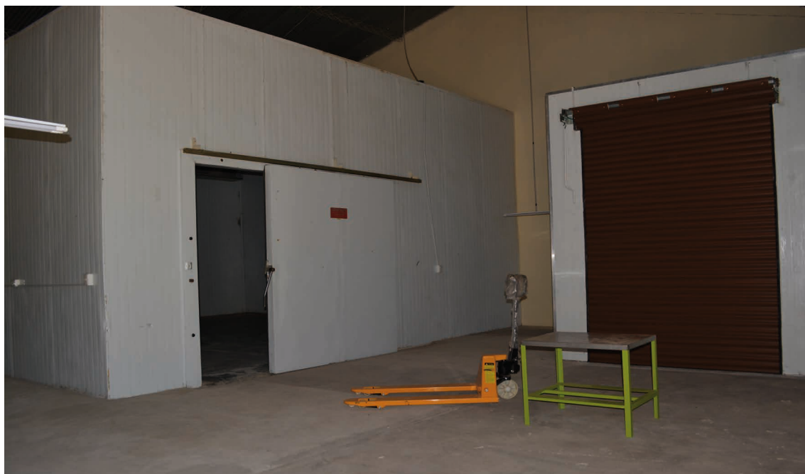
REFACCIÓN DE LA CAMARA DE FRÍO (IZQUIERDA) Y TÚNEL DE FRÍO CONSTRUIDO (DERECHA)
