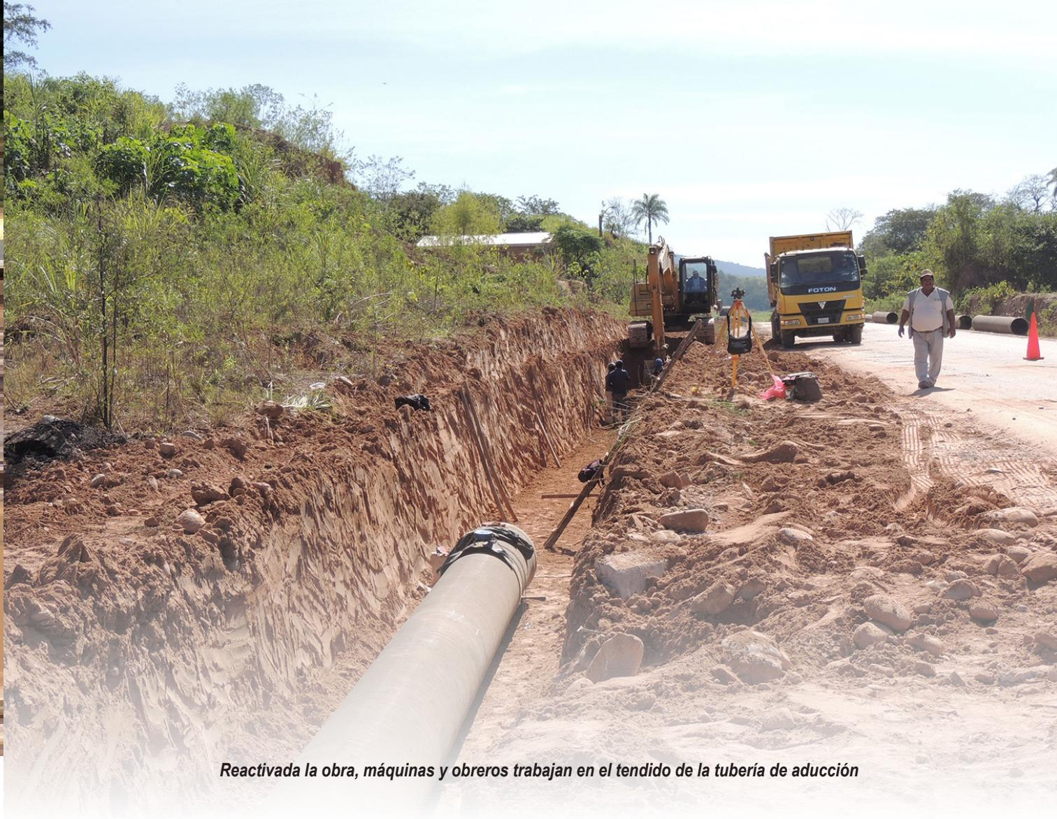
*Reactivada la obra, máquinas y obreros trabajan en el tendido de la tubería de aducción*
