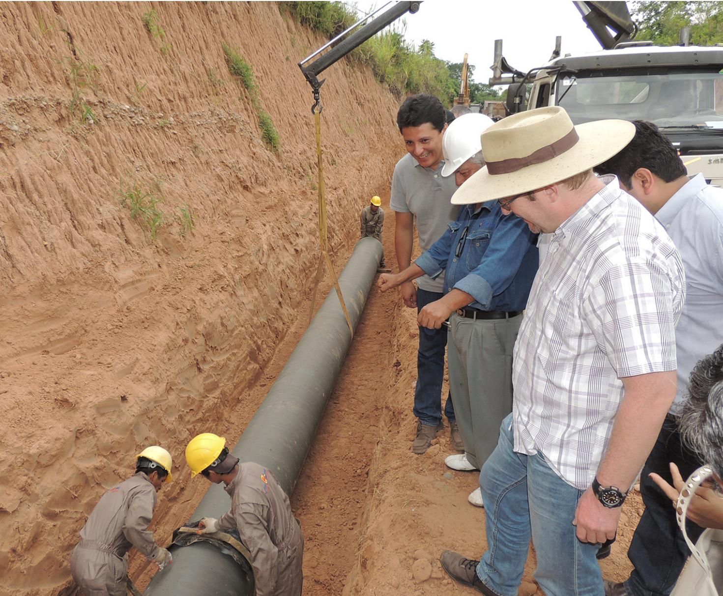
*Reactivada la obra, máquinas y obreros trabajan en el tendido de la tubería de aducción*
