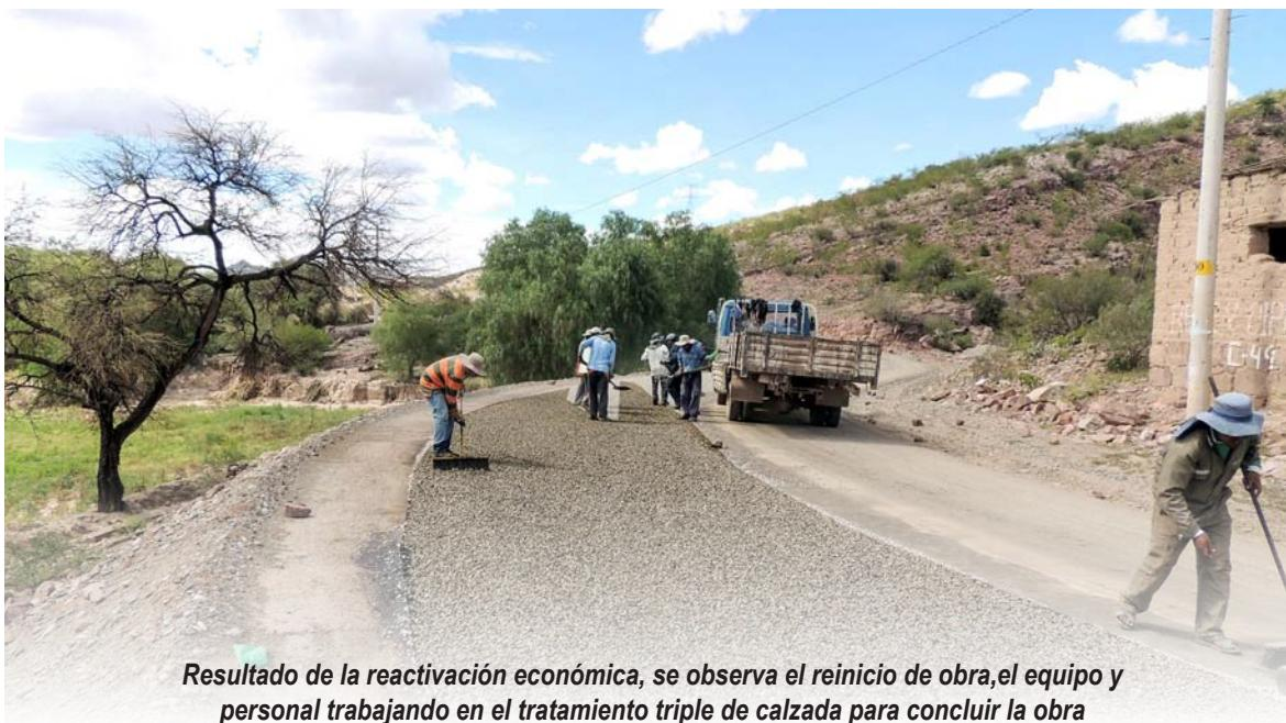
*Resultado de la reactivación económica, se observa el reinicio de obra, el equipo y personal trabajando en el tratamiento triple de calzada para concluir la obra*
