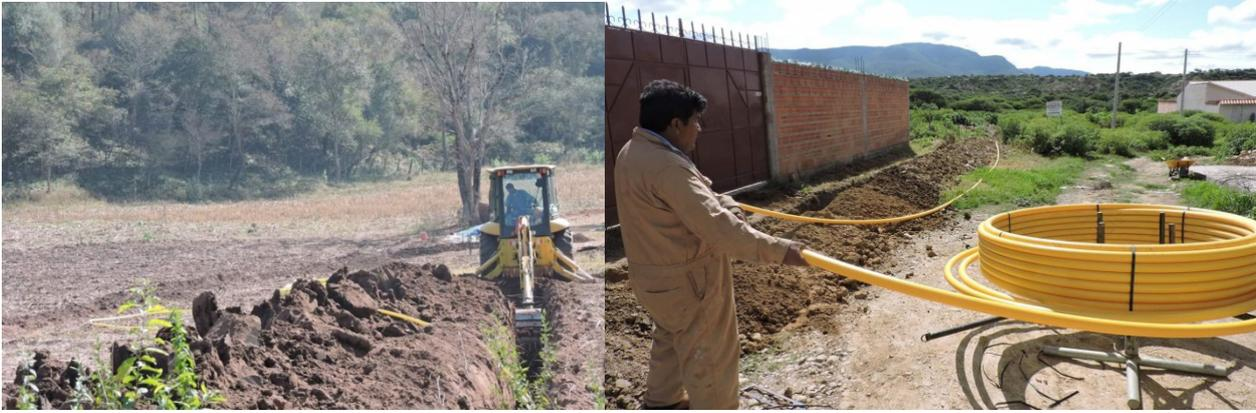
Se realizó el tendido de red secundaria por los distintos barrios de la ciudad; con la consigna de llevar el gas domiciliario a todas las familias tarijeñas. Cabe destacar el esfuerzo de los vecinos de distintas zonas, que colaboran con la excavación de zanjas para el avance de los trabajos.
