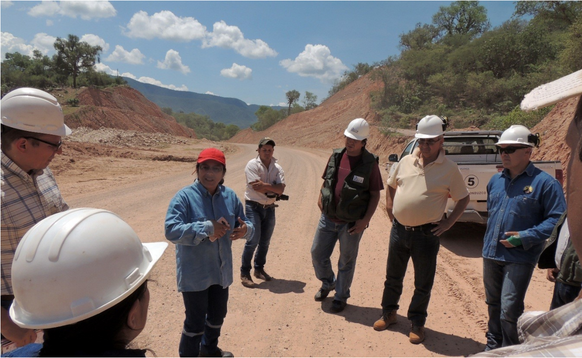
Foto JPL-1 inspección al tramo llevada a cabo el 17 de enero 2018.
