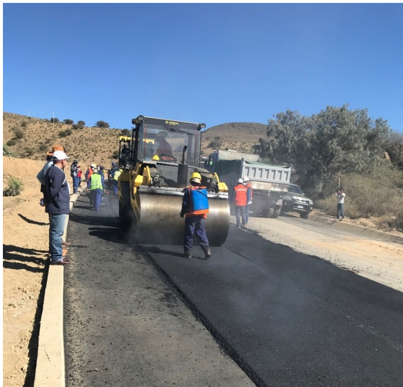
Fotografía. : Inicio de Asfaltado
