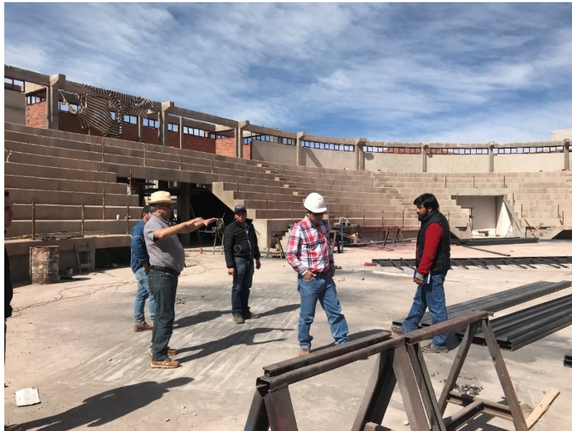
Fotografía. : Inspección de obra en inicio de construcción de la cubierta metálica
