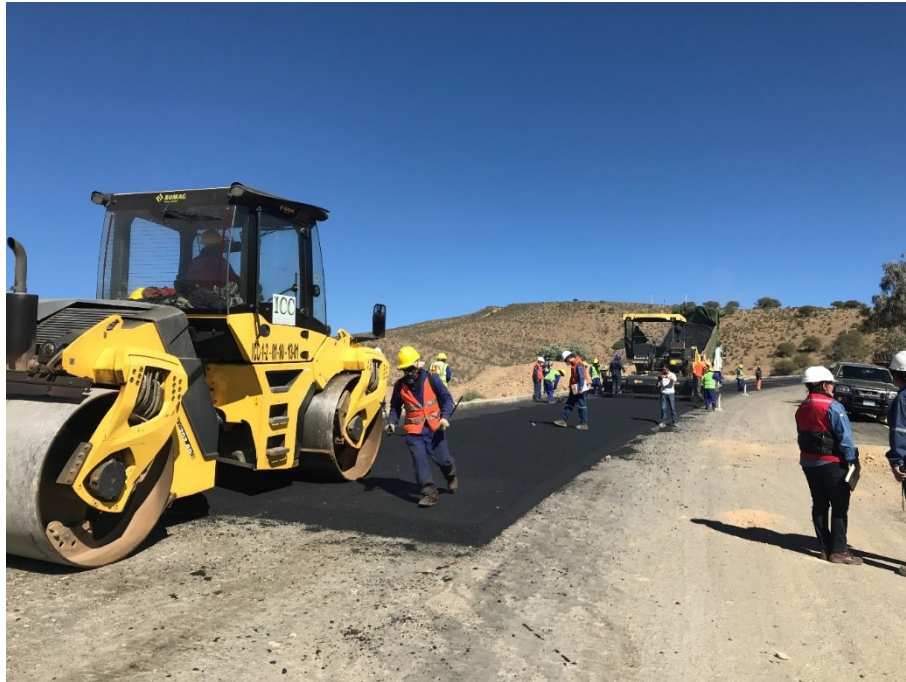
Fotografía. : Inicio de Asfaltado
