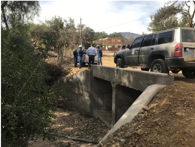
Fotografía. : Inspección de un puente doble cajón
