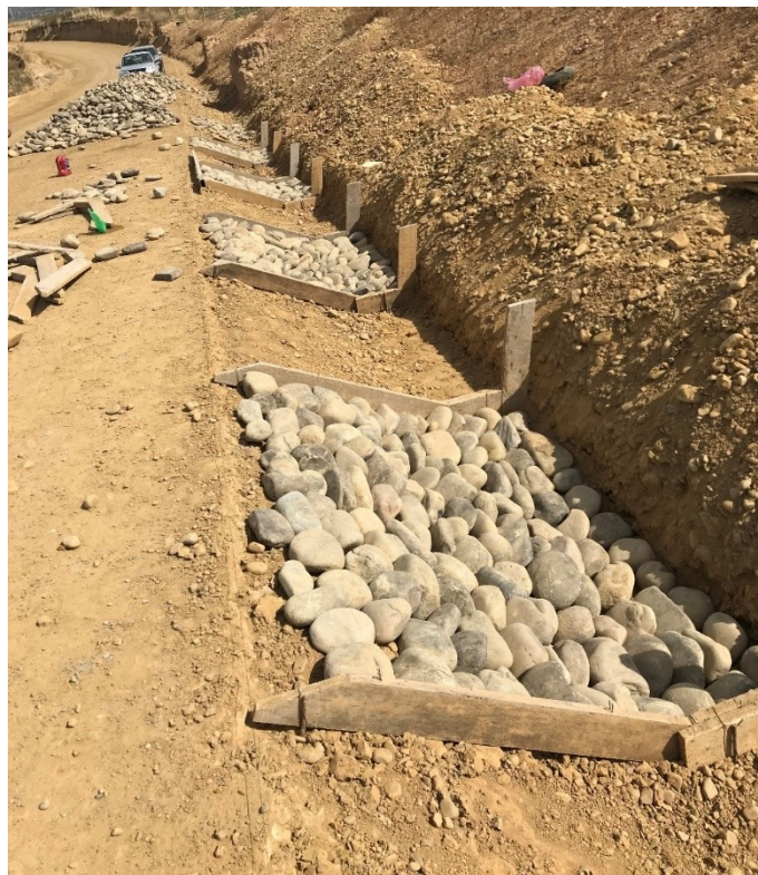
Fotografía. : Ejecución de cunetas de HoCo
