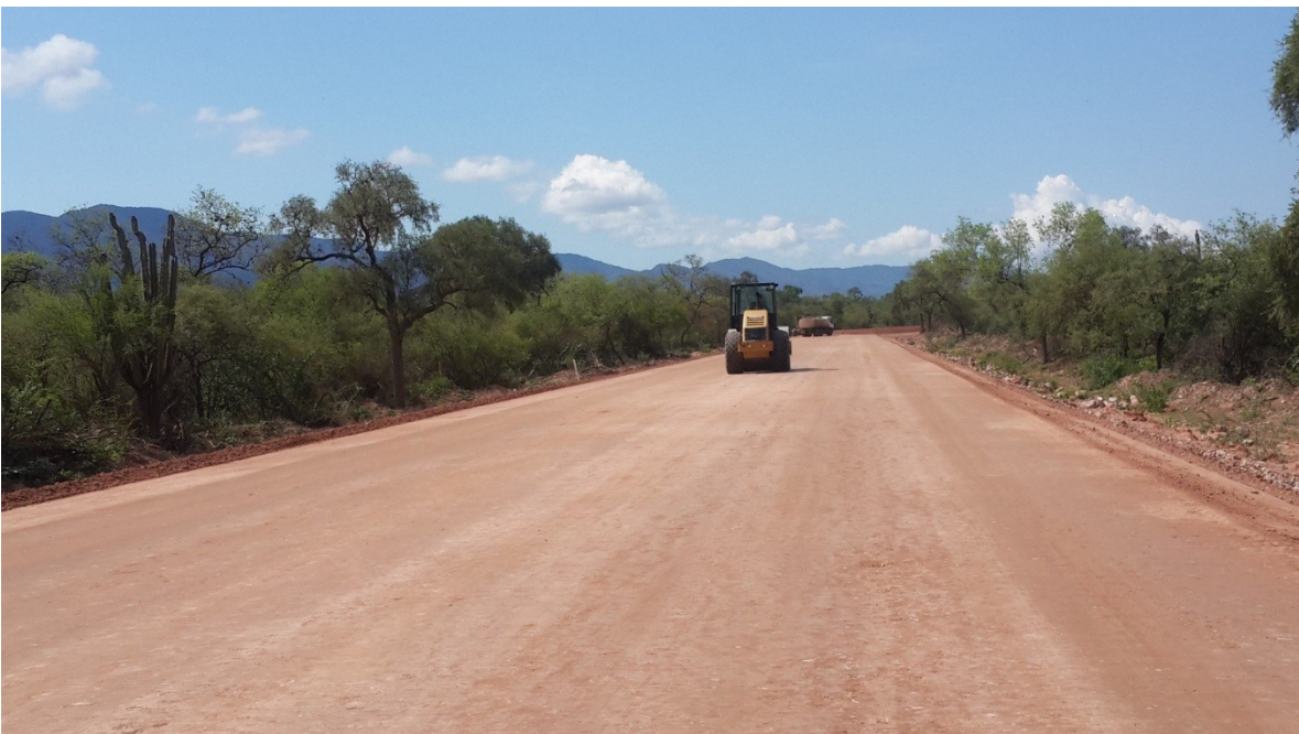
Foto JPL-4 Compactado la capa súbbase de la carretera
