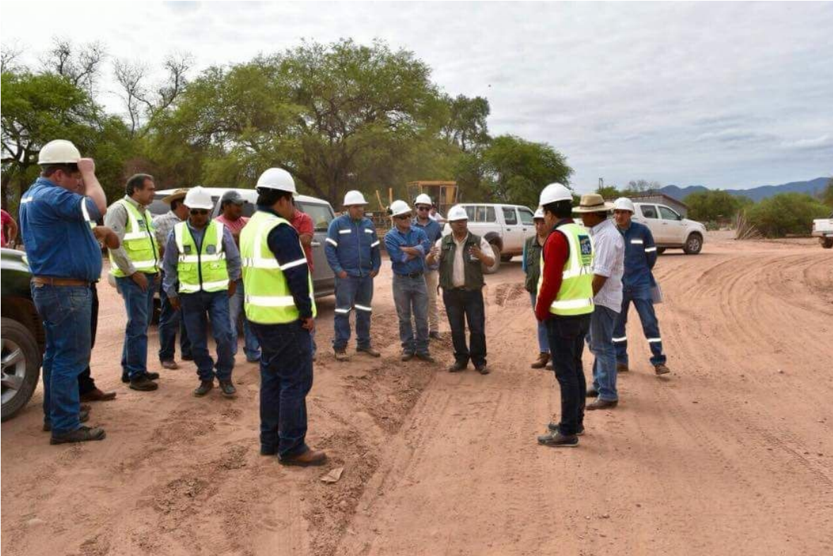
Foto JPL-3 Inspección al tramo conjunta con ABC
