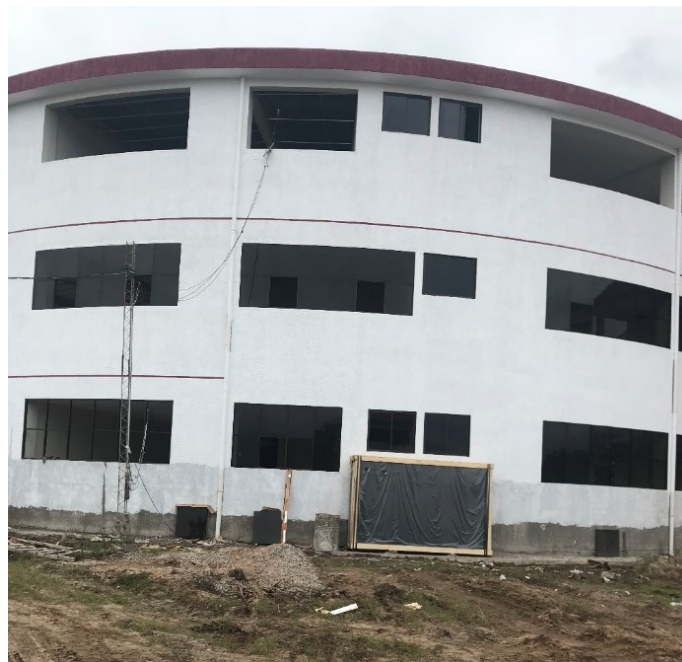
Fotografía: Inspección de fachada lateral del módulo Universitario
