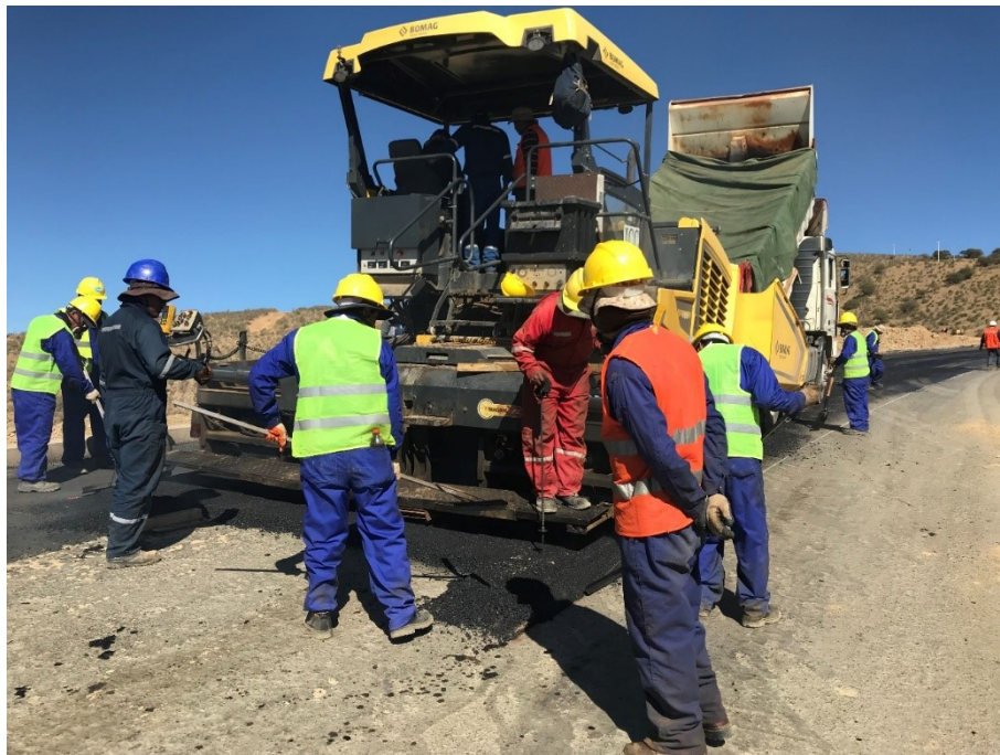
Fotografía. : Inicio de Asfaltado
