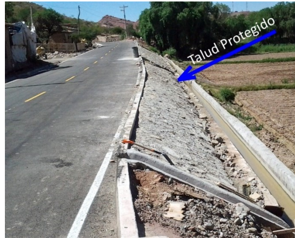
Fotografía: Taludes Protegidos
