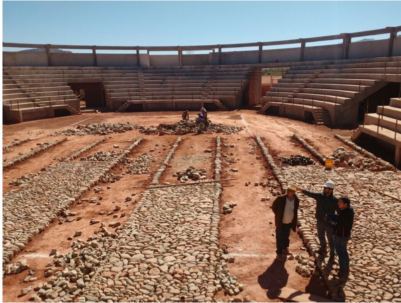
Fotografía. : Inspección de obra en fecha 25/05/2018
