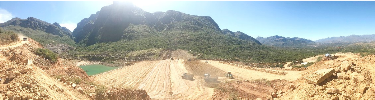
Fotografía.: Inspección a trabajos ejecutados con maquinaria, en Presa de Martos
