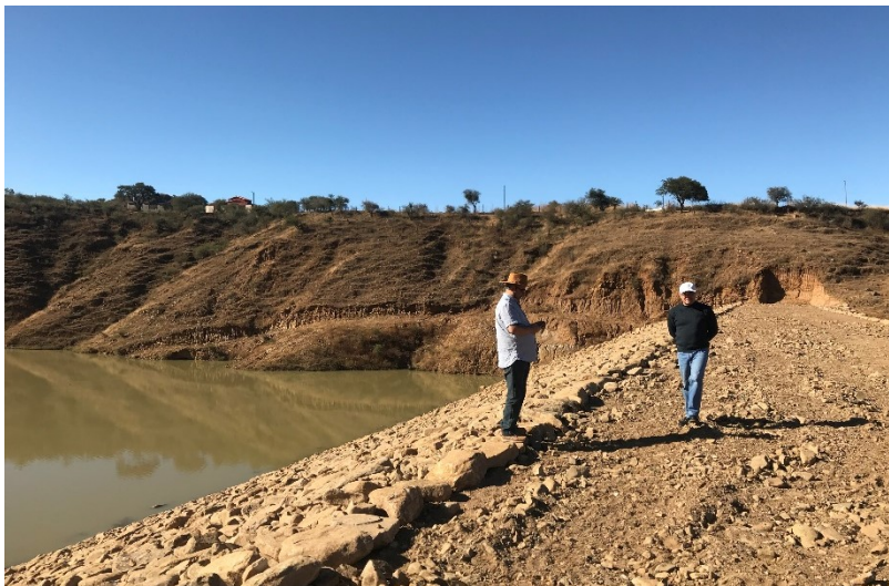
Fotografía. : Inspección a presa El Huayco junto con el Secretario de Gestión Institucional, el Director de Monitoreo y Seguimiento, El Subgobernador de Uriondo, y ejecutivos de la zona
