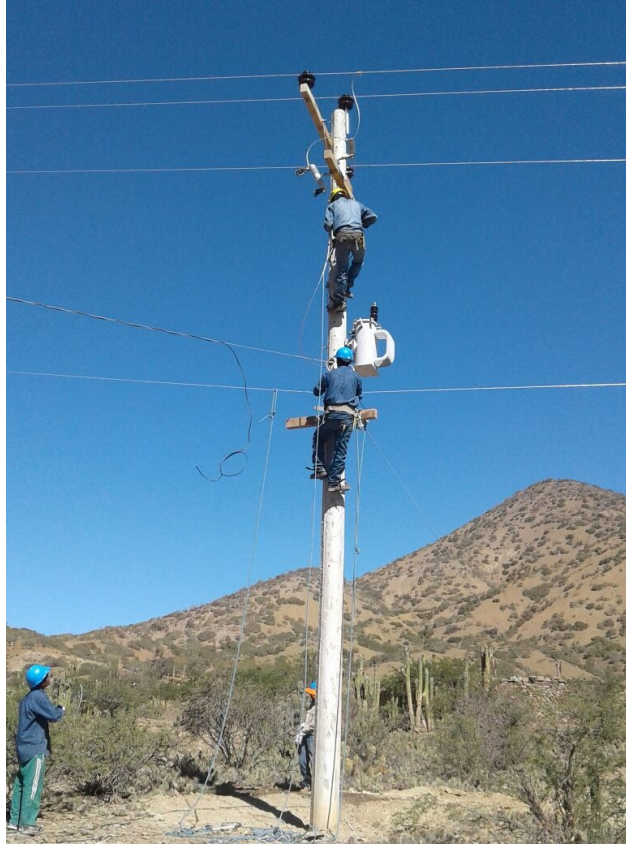
Fotografía.: Ejecución del proyecto AMPLIACIÓN Y MEJORAMIENTO ELECTRIFICACIÓN RURAL 2DA SECCIÓN EL PUENTE
