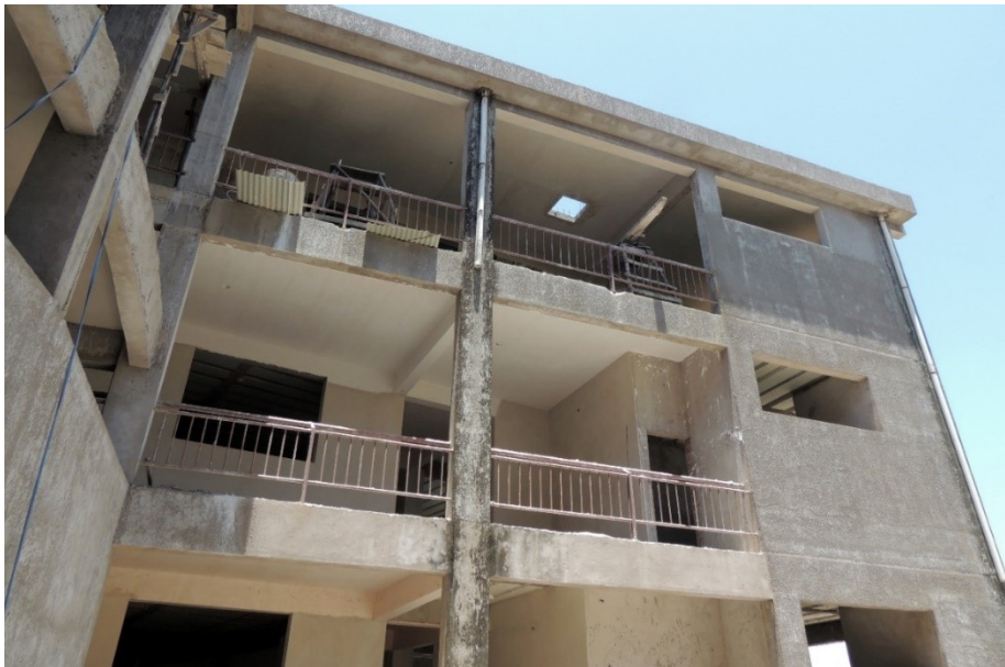
Fotografía CU-2 fachadas exteriores con revoques
