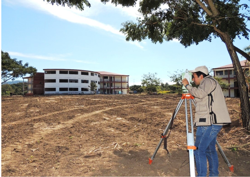
Fotografía. : Levantamiento Topográfico para diseño a accesos internos a Campus Universitario
