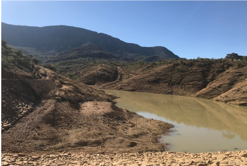
Fotografía. : Inspección a presa El Huayco
