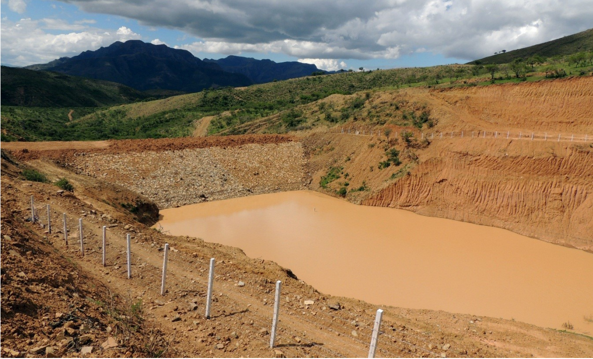
Fotografía.: Presa Montecito se observa el avance de la obra
