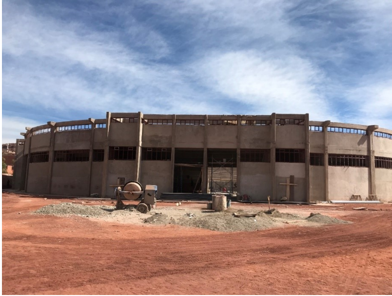
Fotografía. : Inspección de Coliseo Polifuncional para 2.000 personas
