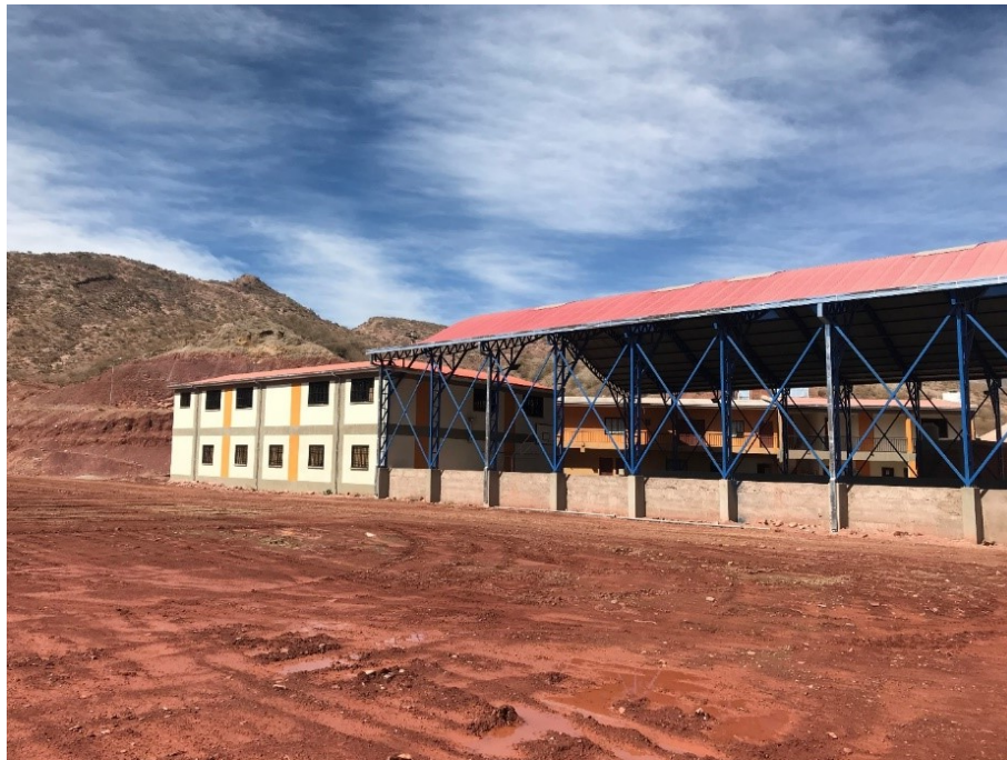
Fotografía. : Inspección de cancha auxiliar de Septapas
