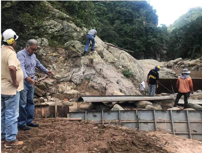
Fotografía. 3: Inspección a la obra de toma en fecha 12 de abril de 2018
