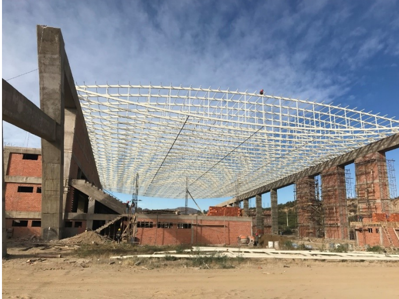
Fotografía. : Estado al mes de Junio de la Piscina Olímpica Departamental de Tarija
