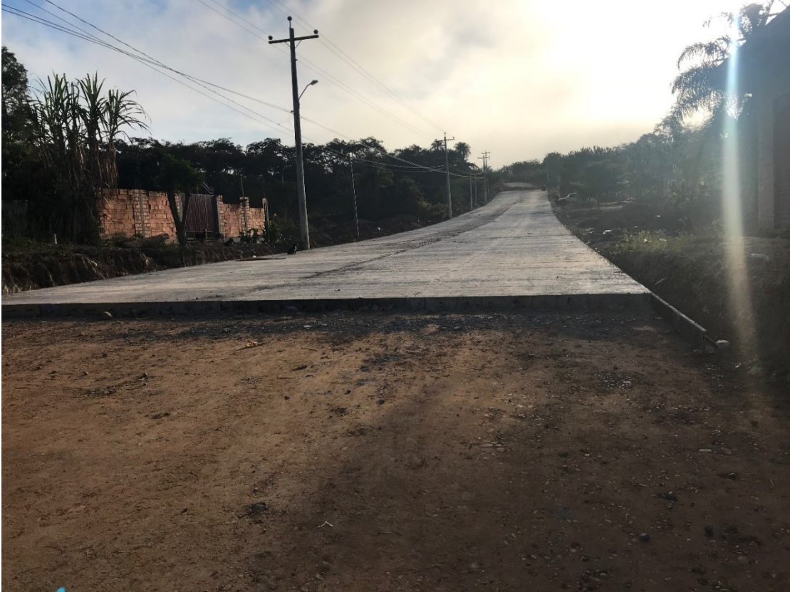
Fotografía: Avance físico del vaciado de pavimento rígido en dirección al Campus Universitario
