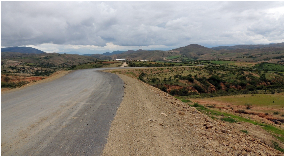
Fotografía. : Inspección de obra
